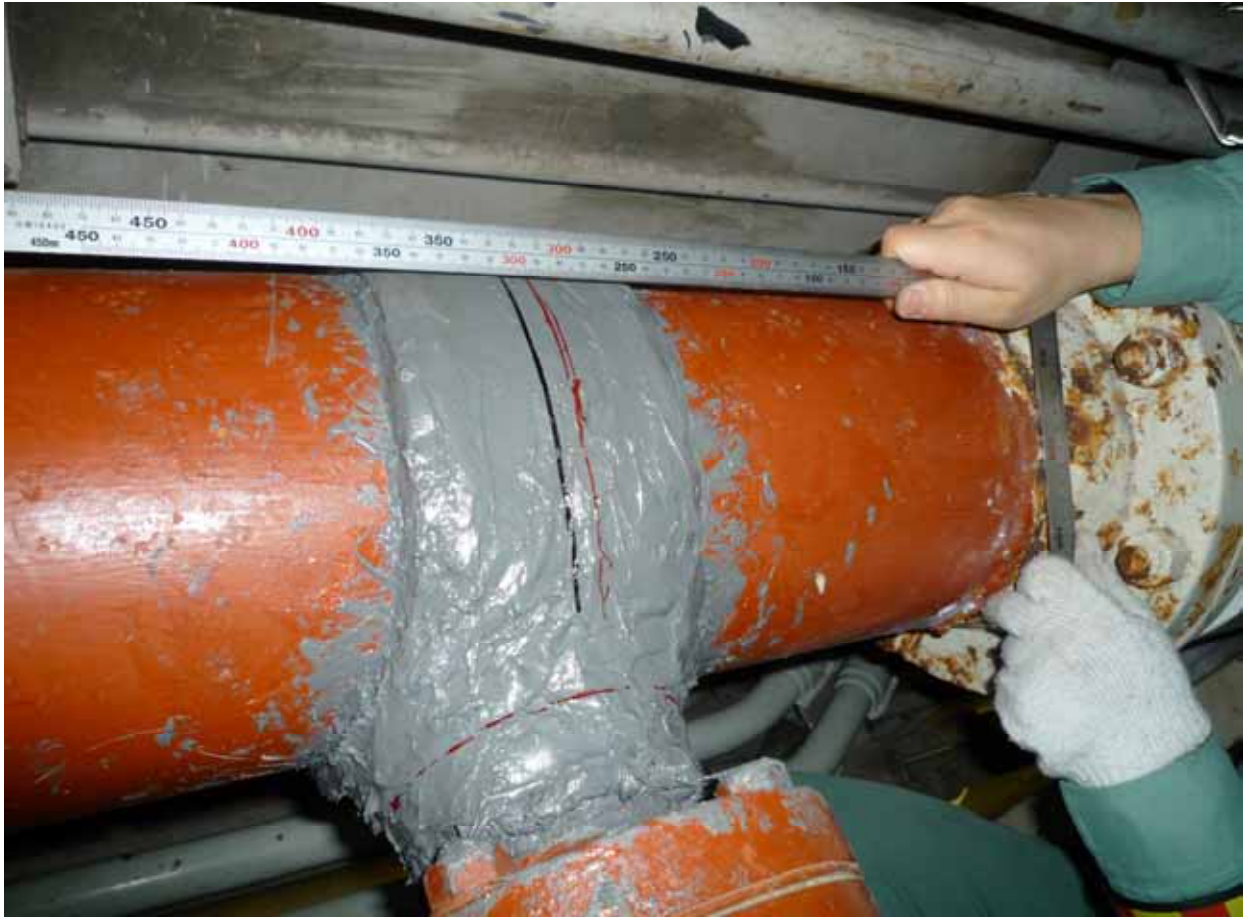
接着材による応急処置状況
