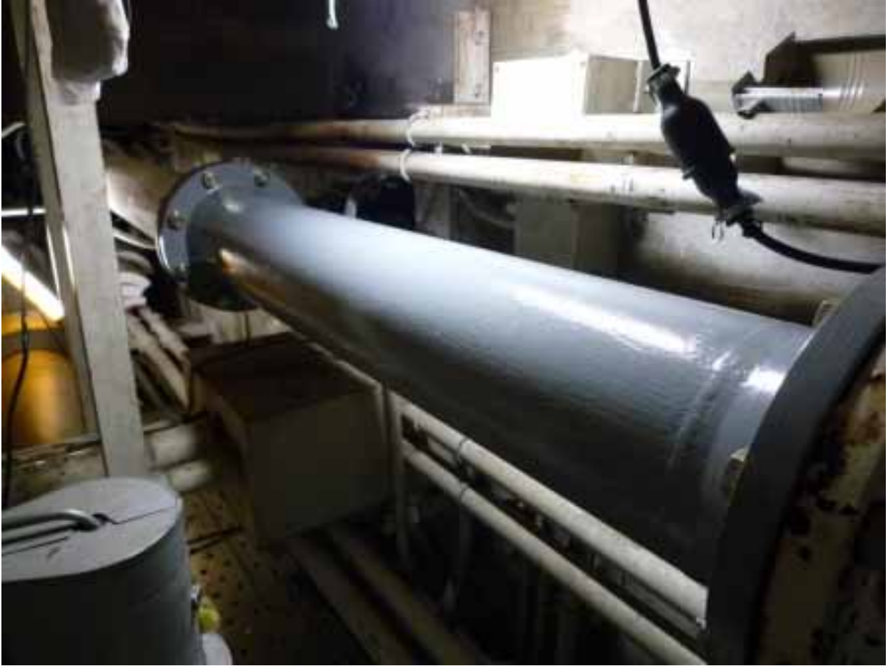
取り替え後の配管
