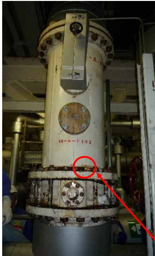
写真 当該配管(保温取外し後)
