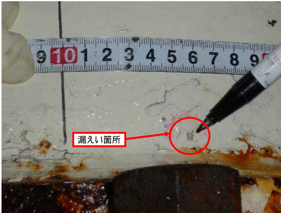
写真 漏えい箇所拡大
