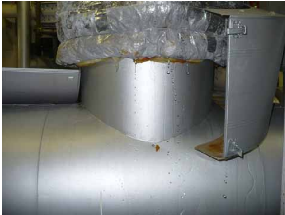
写真 漏えい状況 (保温あり)
