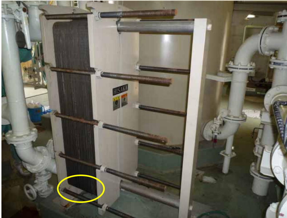
排水冷却器からの水漏れ
