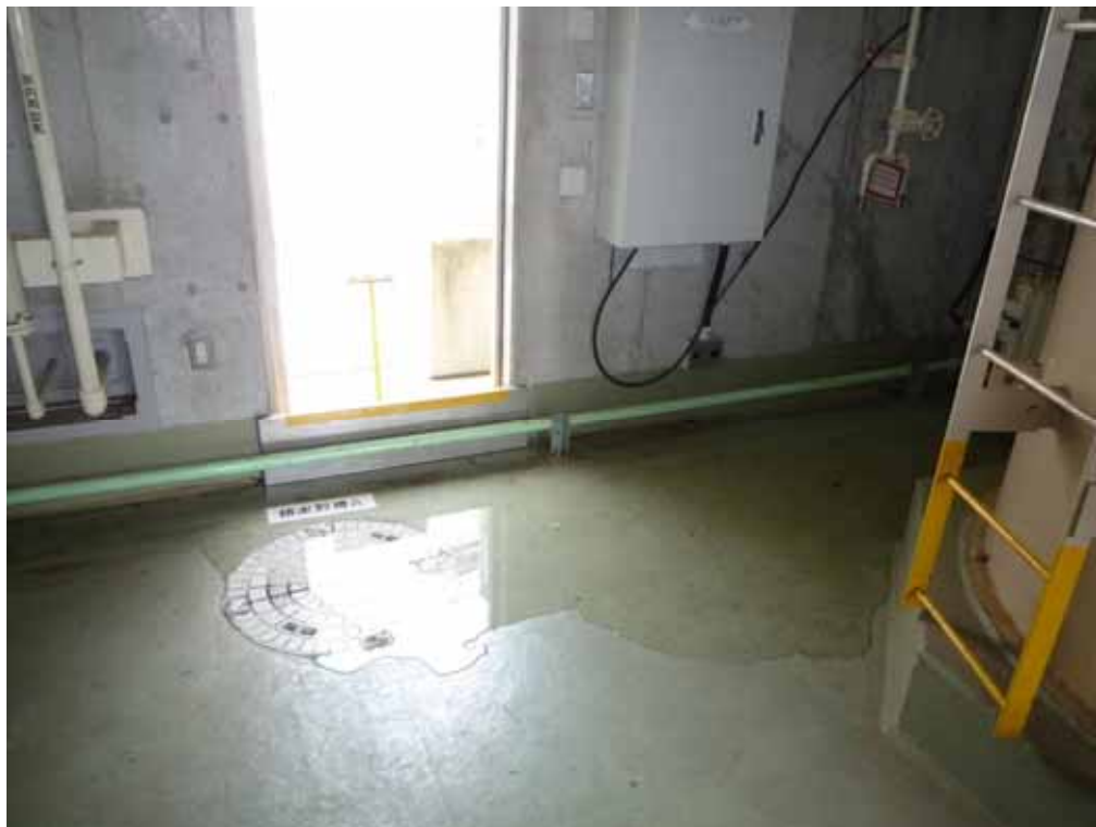
床への水漏れ状況
