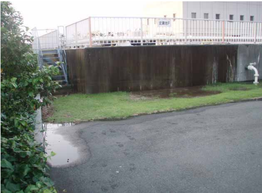
沈殿池の状況
