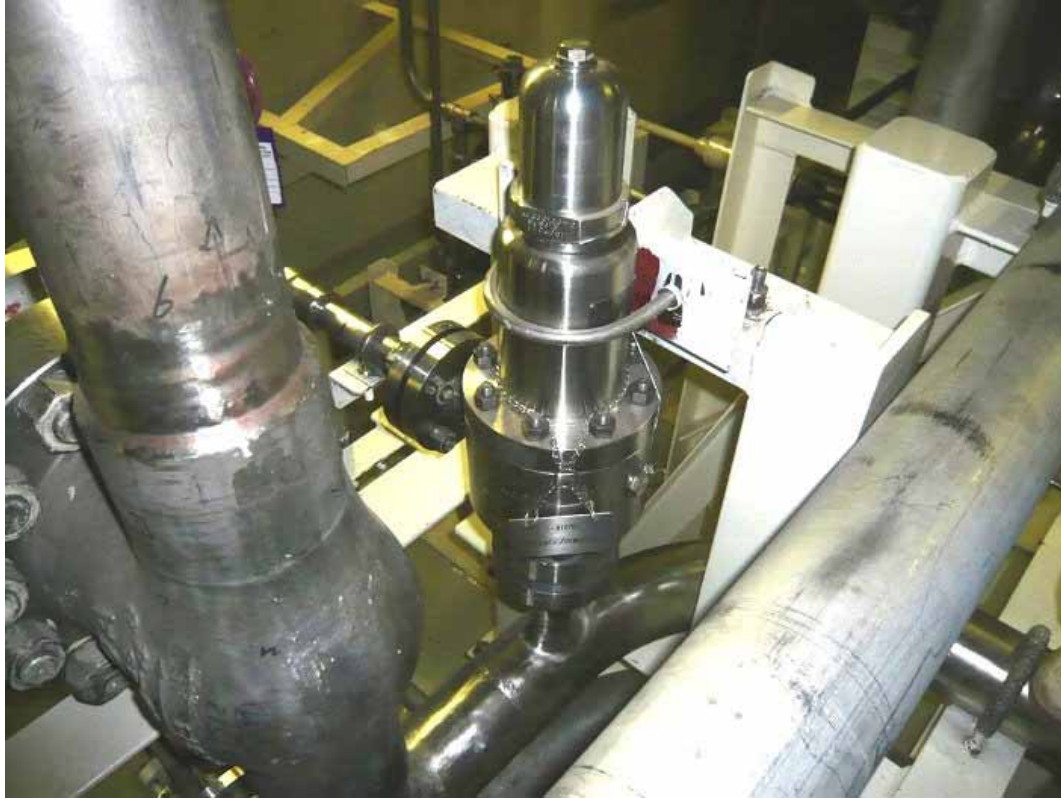
2号機 充てんポンプ2B出口逃がし弁
