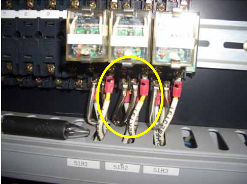
排気ファン 3 B の サージキラー取替前
