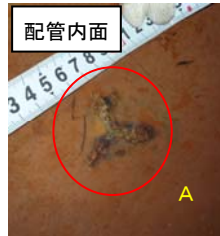
ライニング剥取り・手入れ後
