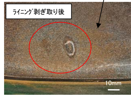
・ライニングは局部的に剥離 ・炭素鋼管内面に全面腐食(ほとんど減肉なし) ・炭素鋼管内面に割れ等の異常はなし
