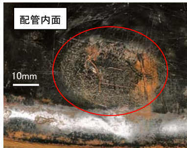
・錆こぶなし ・右側のき裂は軸方向に約 25mm ・左側のき裂は軸方向に約 20mm ・き裂部周辺に比較的大きな外力が加わった跡あり
