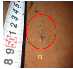
ライニング剥取り・手入れ後
