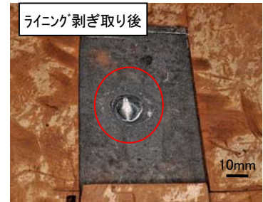
・ライニングは局部的に剥離 ・炭素鋼管内面に全面腐食(ほとんど減肉なし) ・炭素鋼管内面に割れ等の異常はなし
