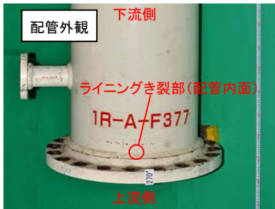
・き裂部は上流側フランジから約 20mm
