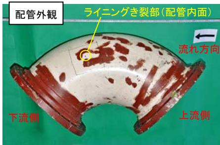
・き裂部は下流側フランジから約 435mm の横腹
