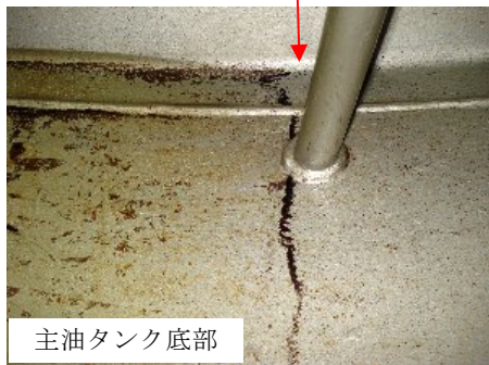
(主油タンク底面 上部より撮影)
