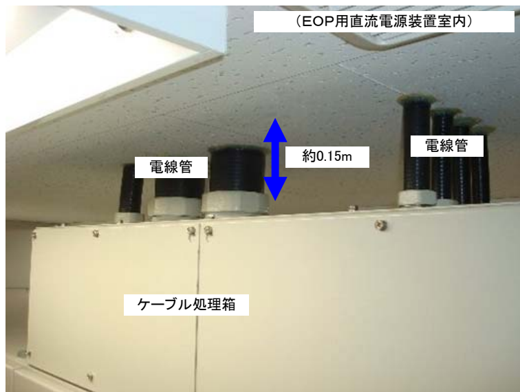
EOP用直流電源装置室の状況(写真)
