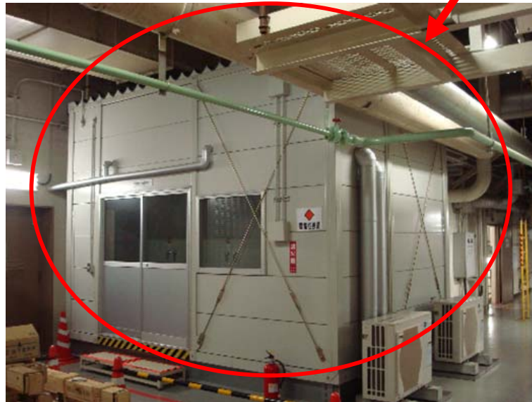
EOP用直流電源装置室
