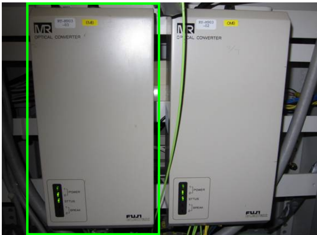
光コンバータ (左側の光コンバータを取替)
