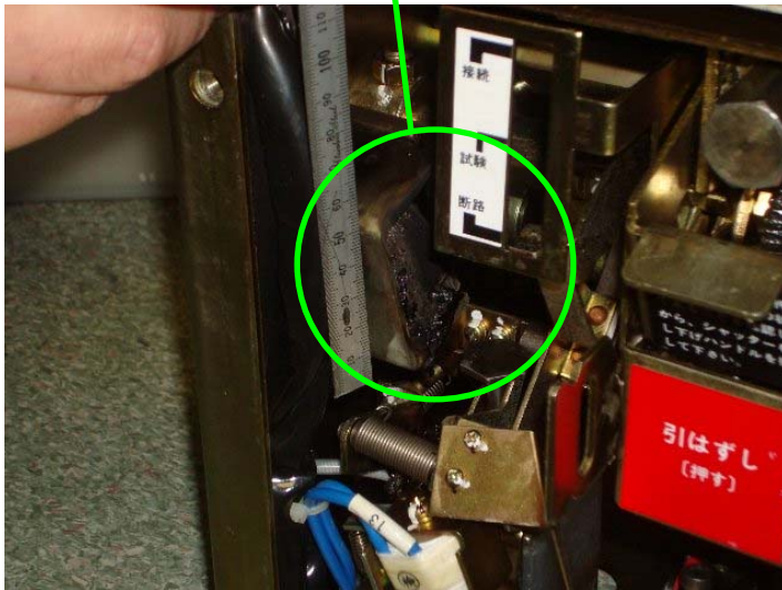
排気ファン3 B内の損傷したトリップコイル
