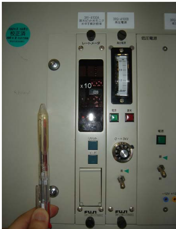
現場指示計 (新品) 取付状態
