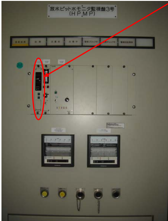
3号機現場 監視盤 (前面)
