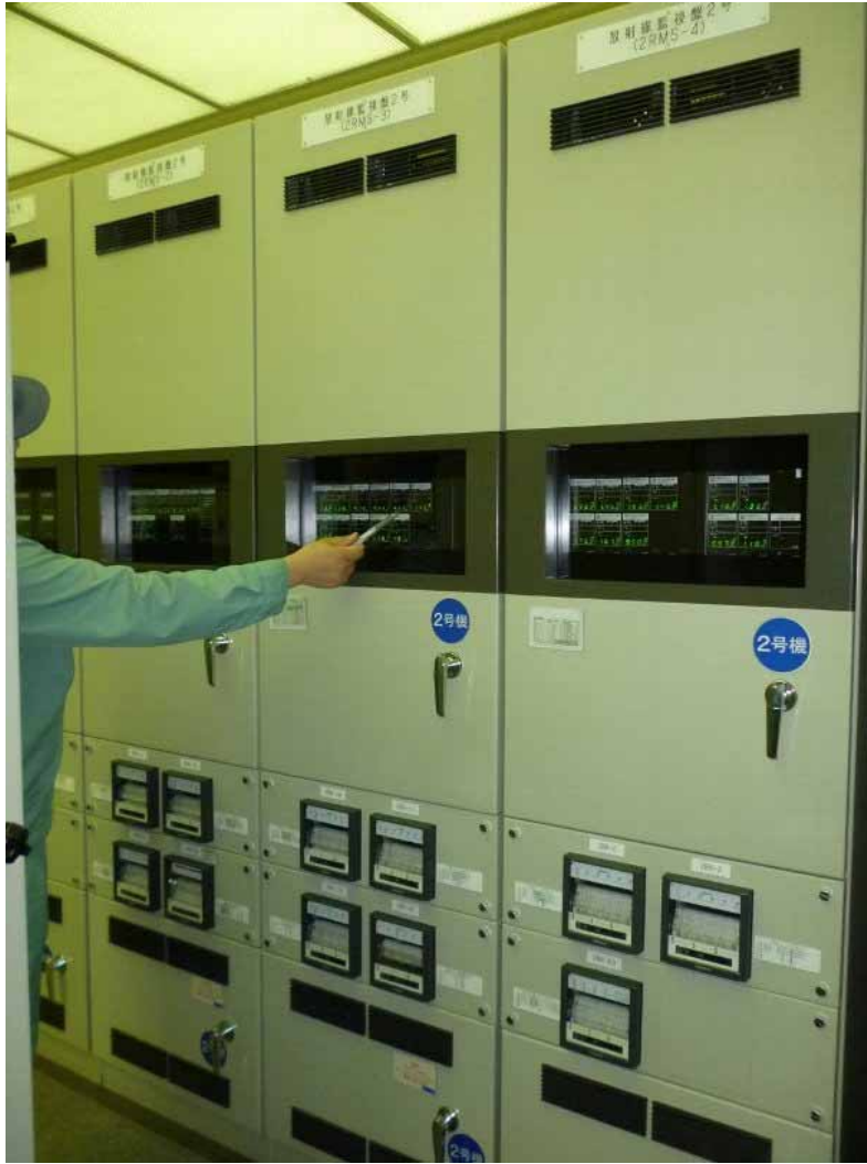
放射線監視盤 2 号（中央制御室）
