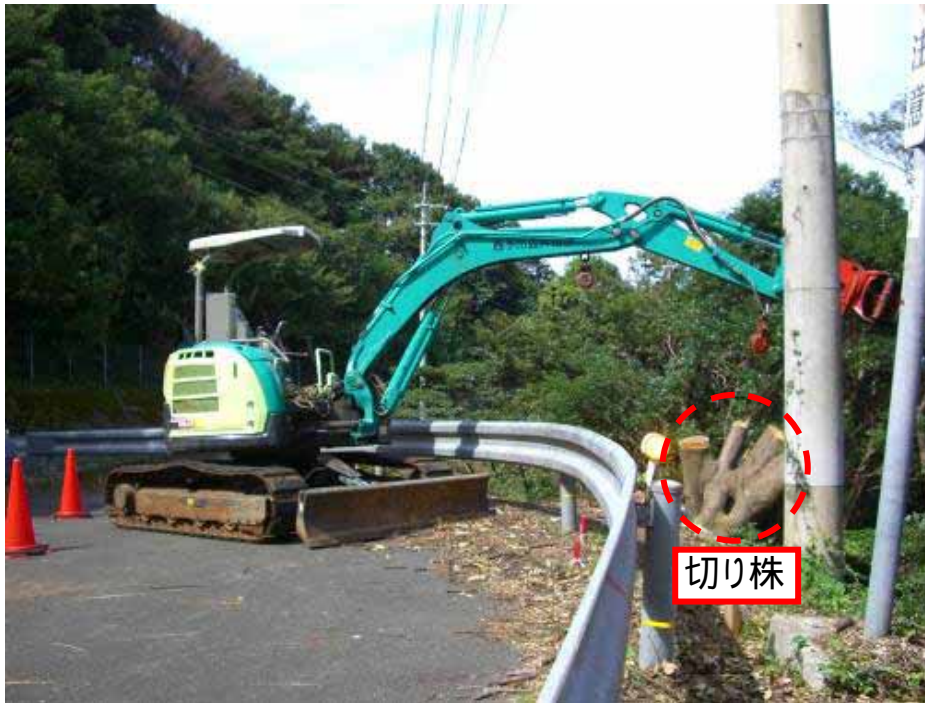
伐採作業場所
