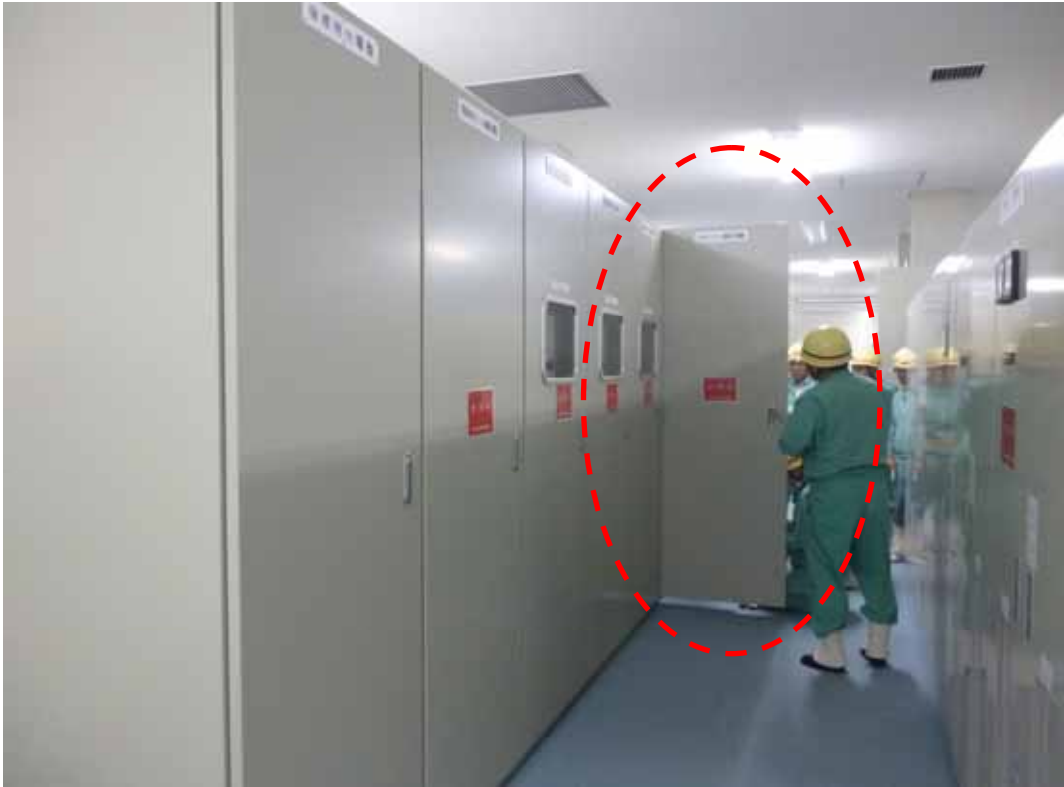
新事務所 4 階分電盤
