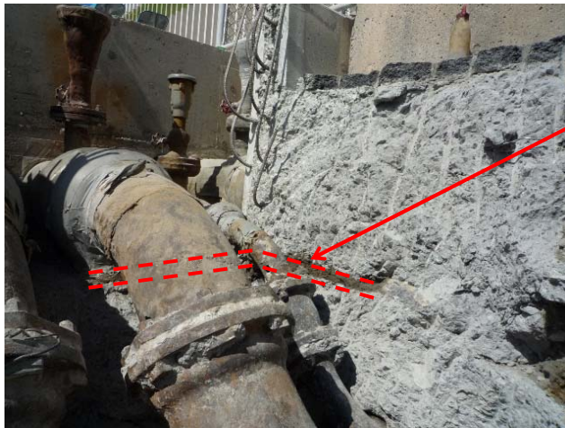
タービン建家常用排水ポンプ出口排水配管部
