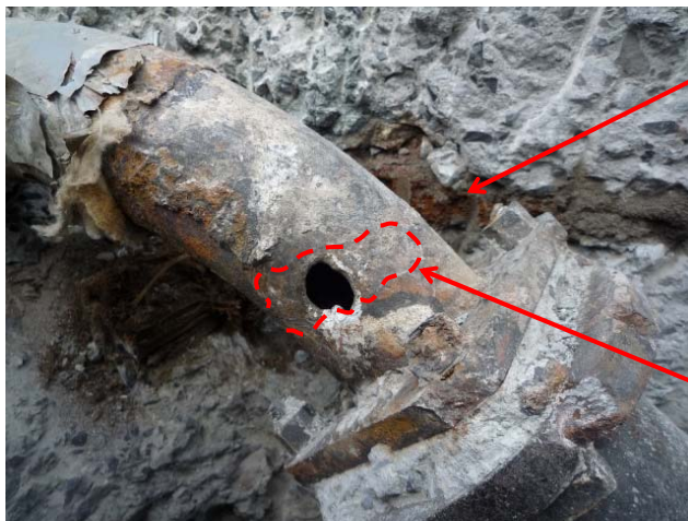
タービン建家常用排水ポンプ出口排水配管損傷部
