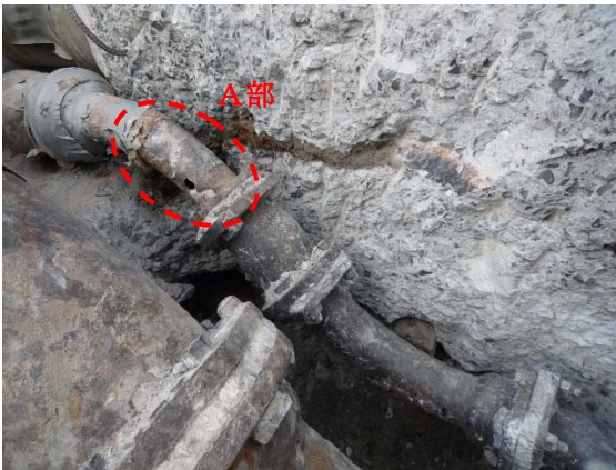
タービン建家常用排水ポンプ出口排水配管
