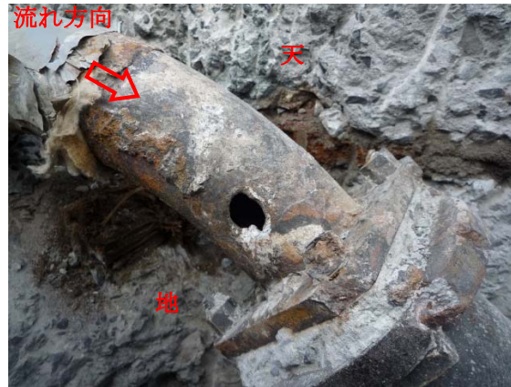
A部（損傷箇所）
