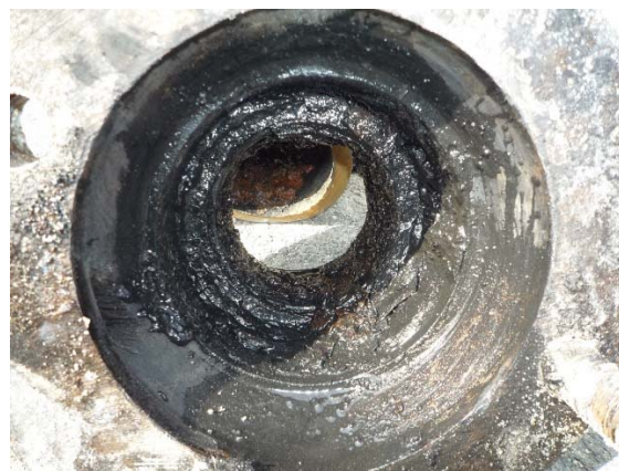
C矢視 (下流側フランジ部)
