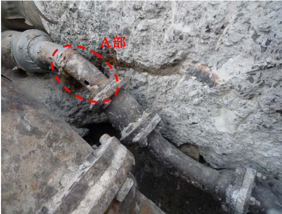
タービン建家常用排水ポンプ出口排水配管
