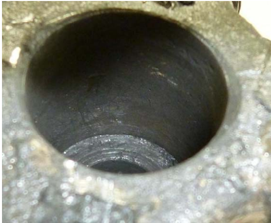
弁フタ (グランドパッキン挿入部)
