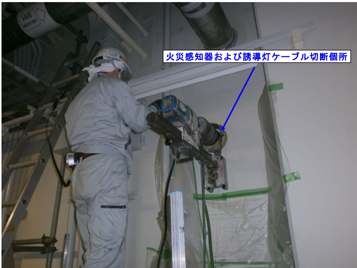
【コア抜き施工状況】火災感知器および誘導灯ケーブル切断箇所
