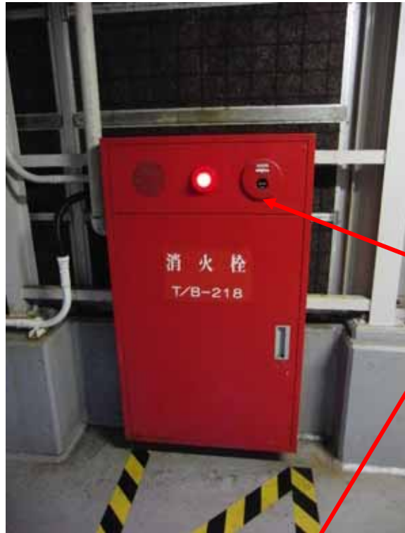
消火栓ボックス
