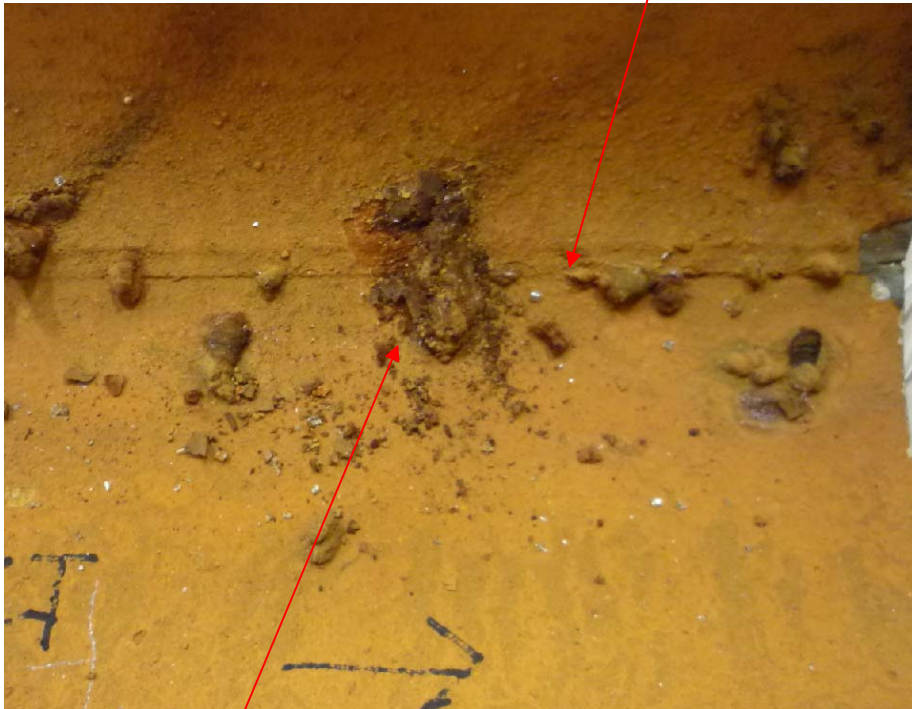
配管溶接部(長手方向)
