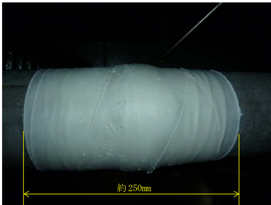
応急補修状況
