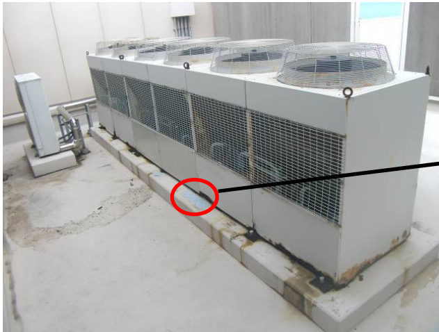
【屋上】空調機室外機状況写真
