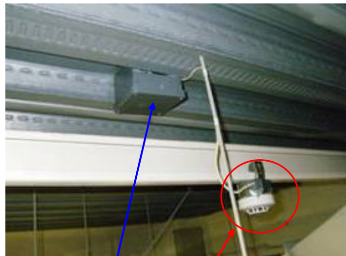
移設取替後状況写真
