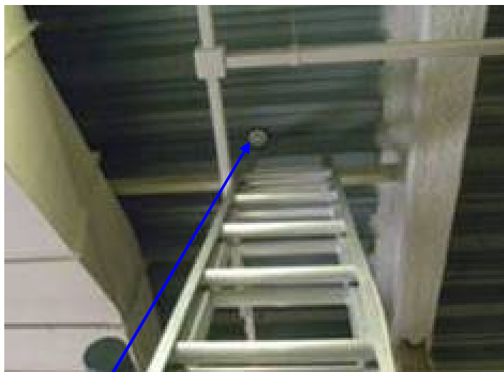
移設取替前状況写真
