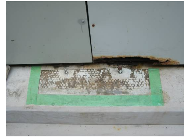
室外機支持用アンカー部防水撤去写真
