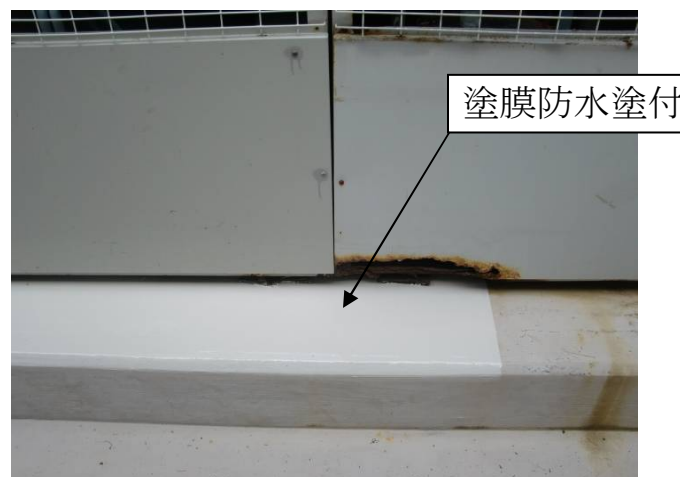
B部（塗膜防水塗付状況写真）
