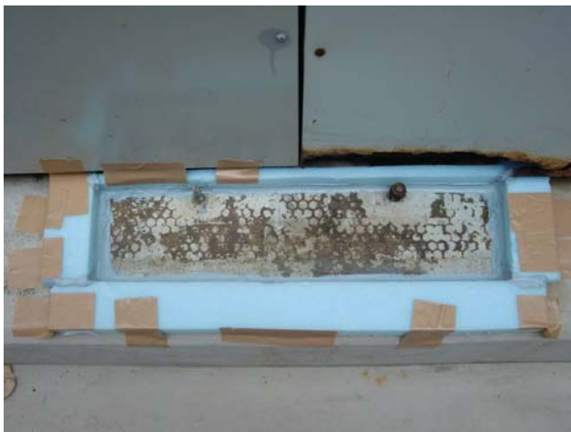
水溜試験状況写真
