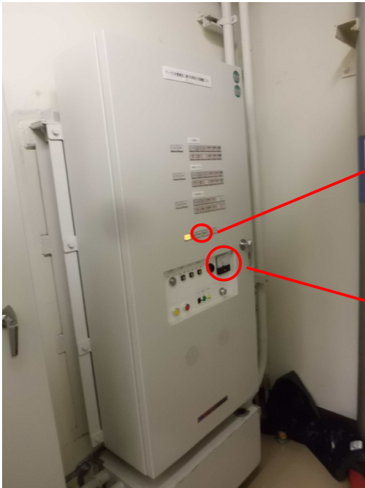
○非常用ディーゼル発電機室 二酸化炭素消火設備盤3A
