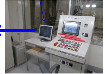
モニタ設置箇所(仮設)
