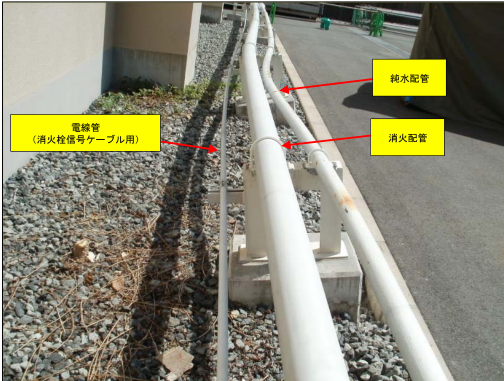
純水配管、消火配管および電線管状況写真（取替前）
