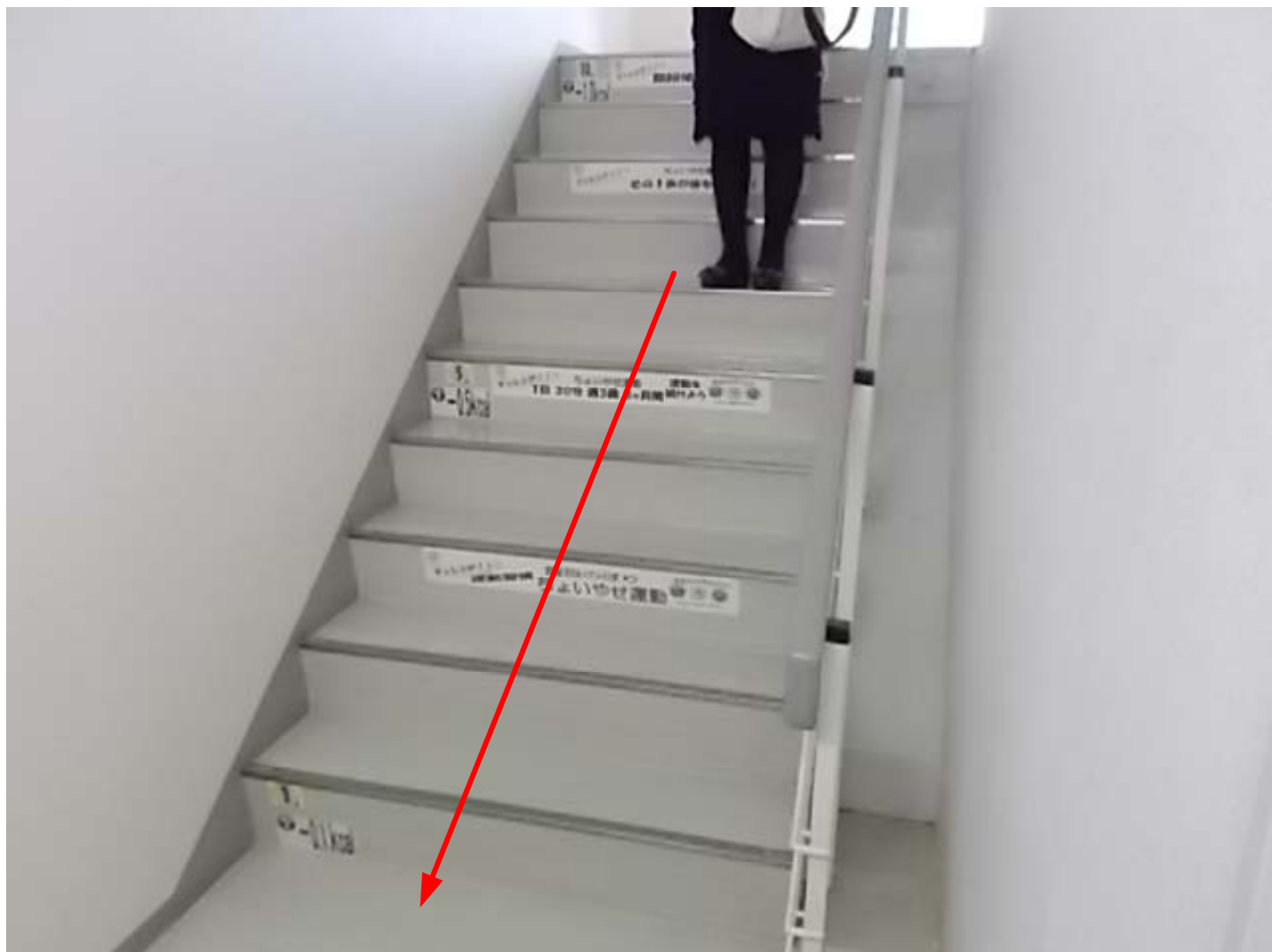
伊方発電所総合事務所内 階段(1階と2階の間)
