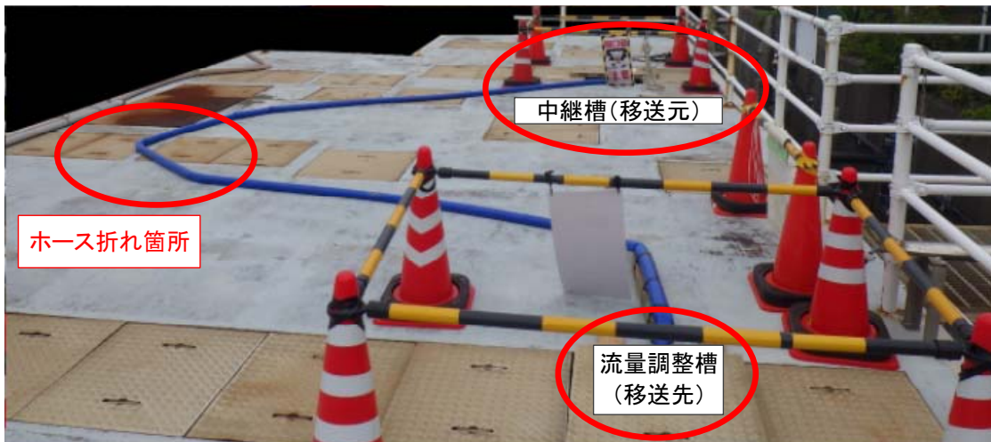
排水貯槽 上面
