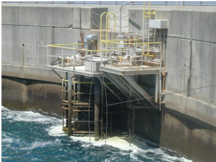
伊方1, 2号機放水口水モニタ設置状況
