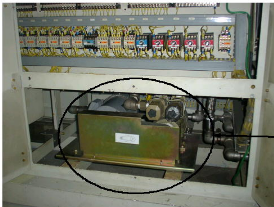
伊方2号機格納容器じんあい・ガスモニタ用真空ポンプ
