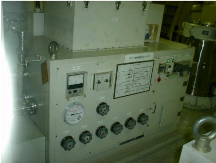
伊方2号機格納容器じんあいモニタ及びガスモニタ（右奥）
