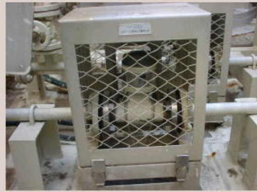
電磁流量計 (潤滑水流量計)
