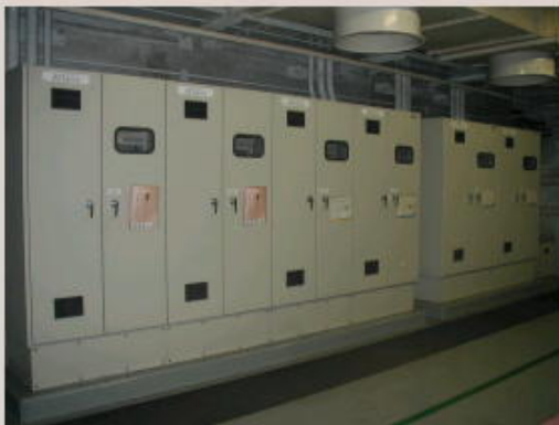
電磁流量計盤
