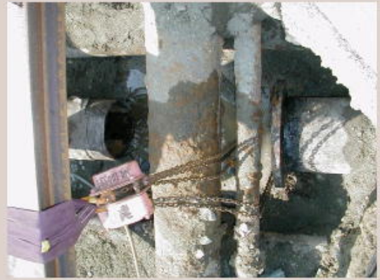
切り離し状況
