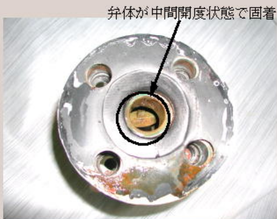
逆止弁手入れ前 (下流側から撮影)
