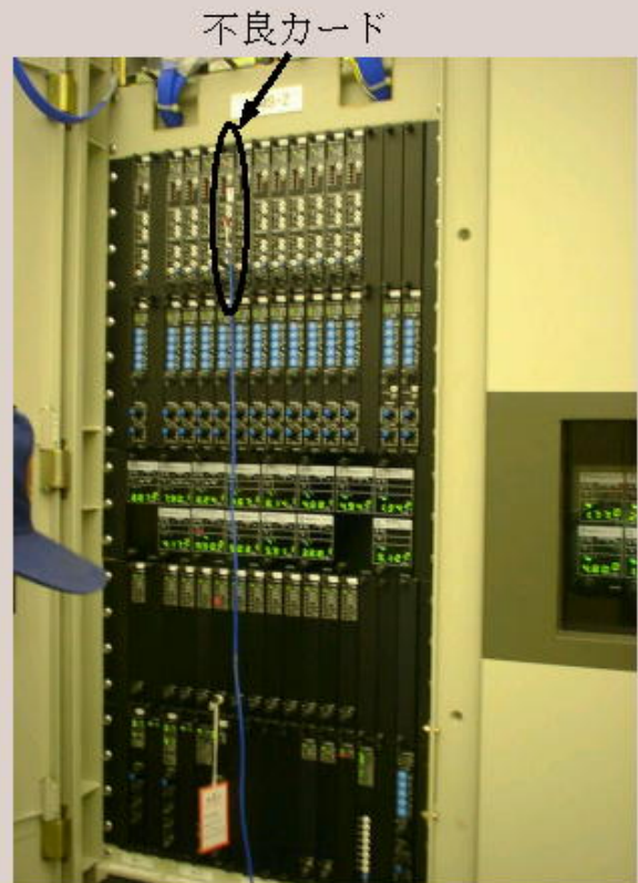
放射線監視盤内部
