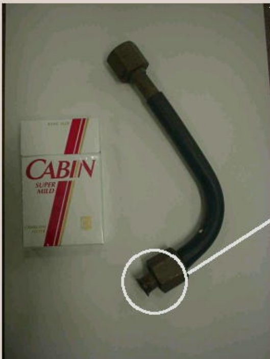
割れのあった配管
