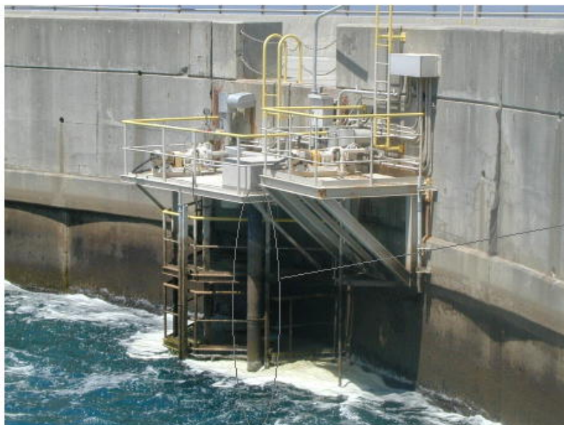
伊方1, 2号機放水口水モニタ設置状況
