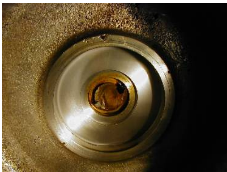
モータ側 (中心部の赤褐色の部分が折損した主軸)
