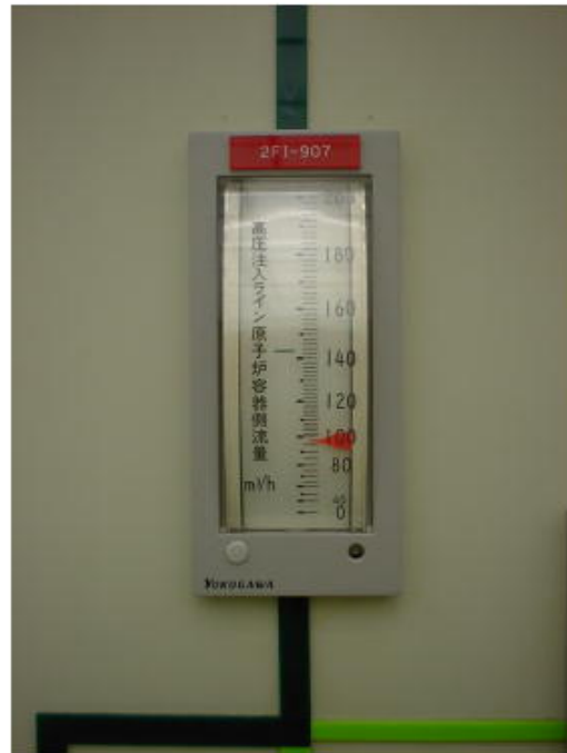
流量計（中央制御室）
