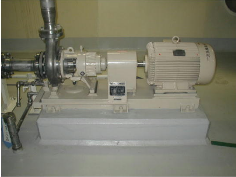
補給水ポンプ全景
