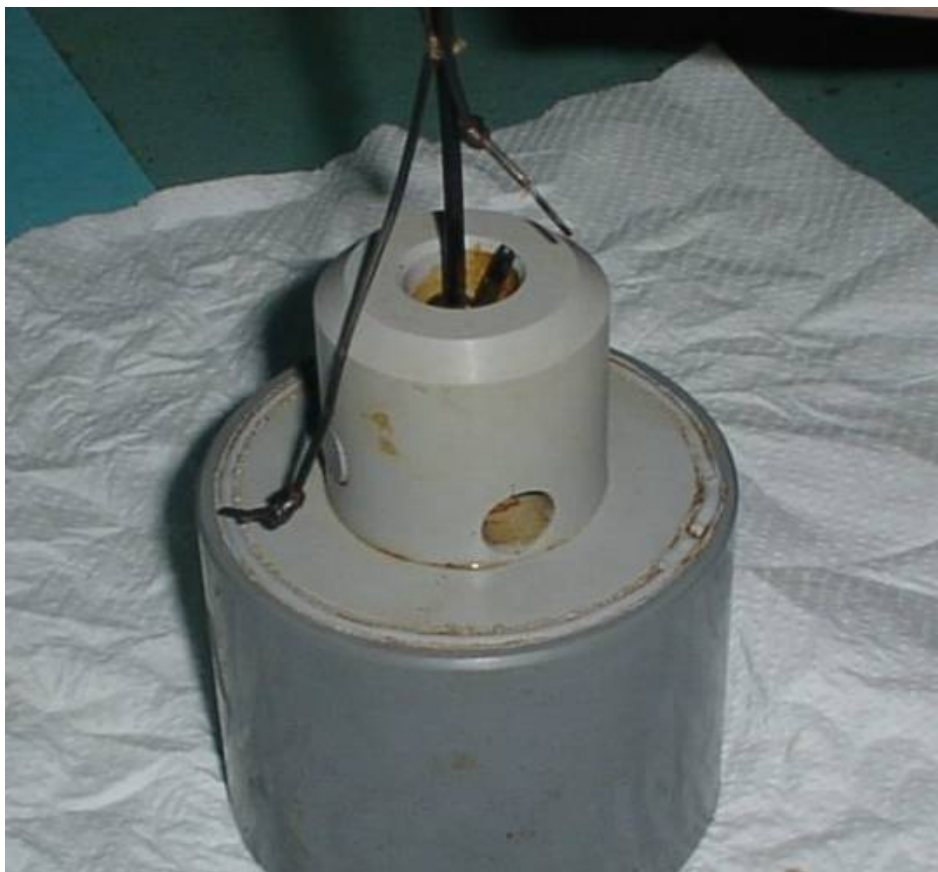
濃縮海水槽水位スイッチ点検後
