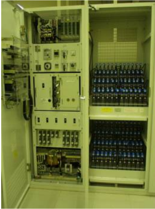
開閉所直流電源装置 A 全景
