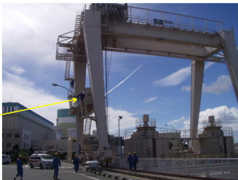
取水ピットクレーン全景
