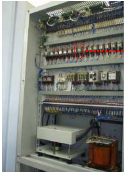
開閉所直流電源装置3A背面
