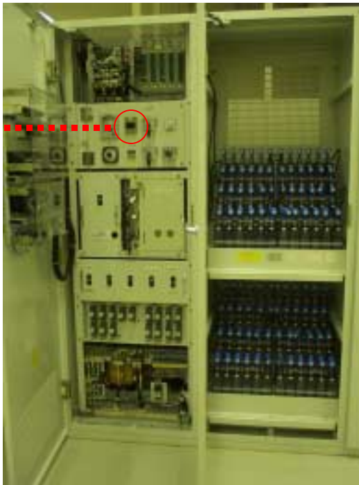
開閉所直流電源装置3A全景
