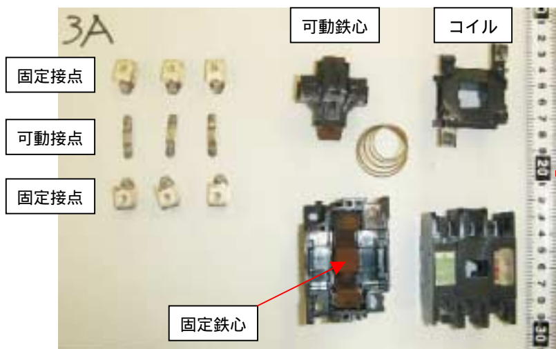
電磁接触器(3A)分解状況
