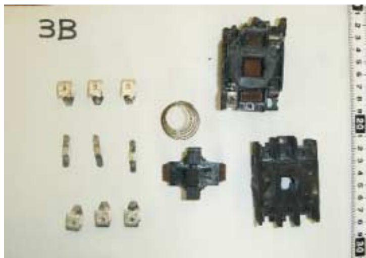
電磁接触器(3B)分解状況
