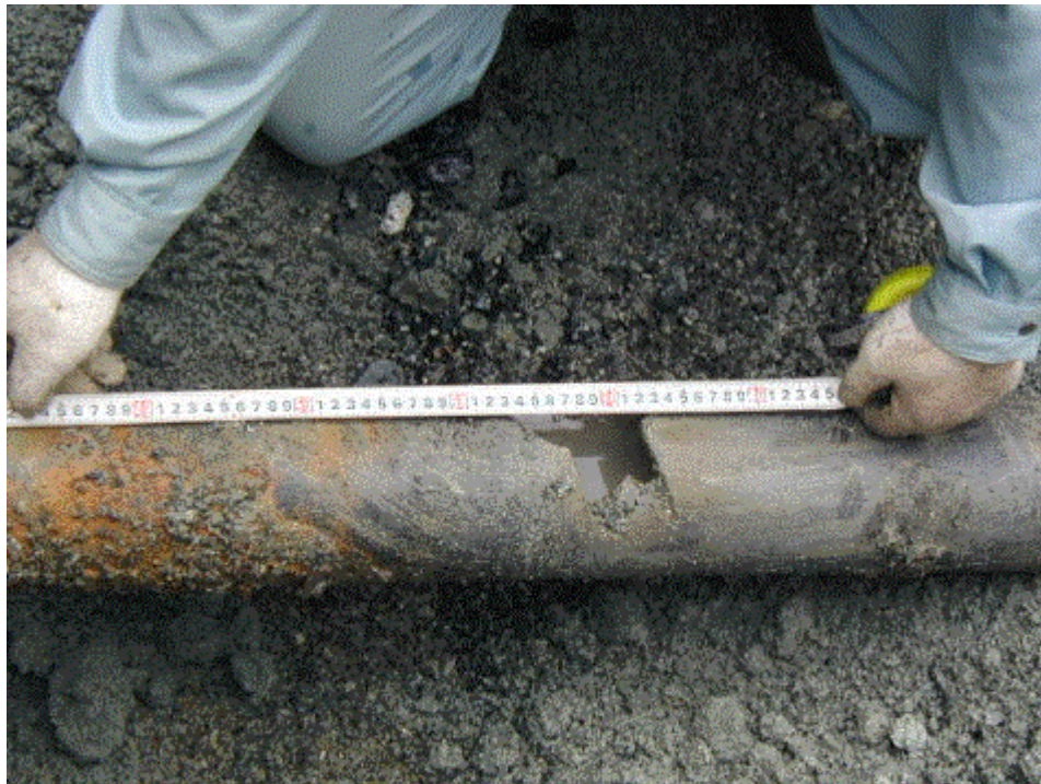
埋設消火配管損傷状況
