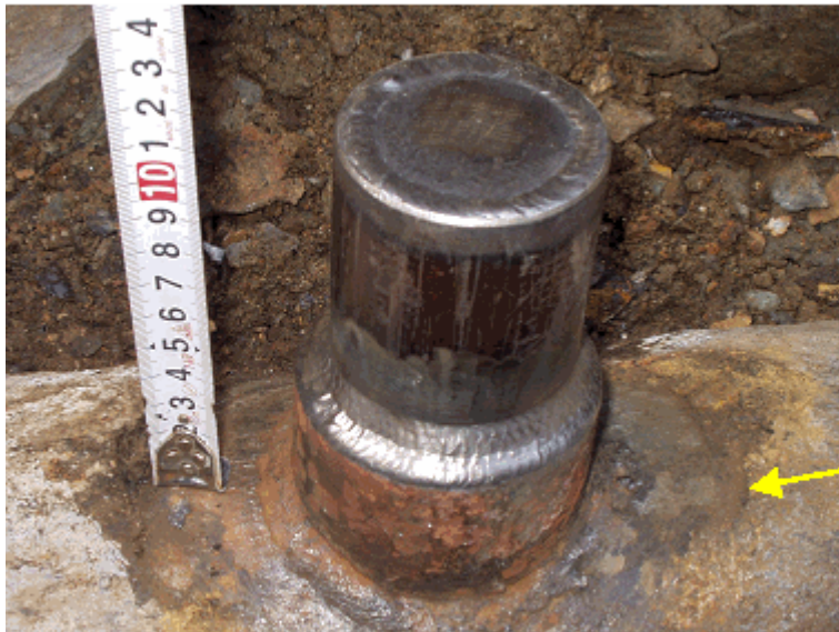
復旧後 (閉止蓋を取付けた状態)
