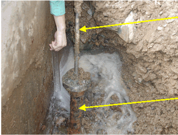
ろ過水配管からの漏えい状況
