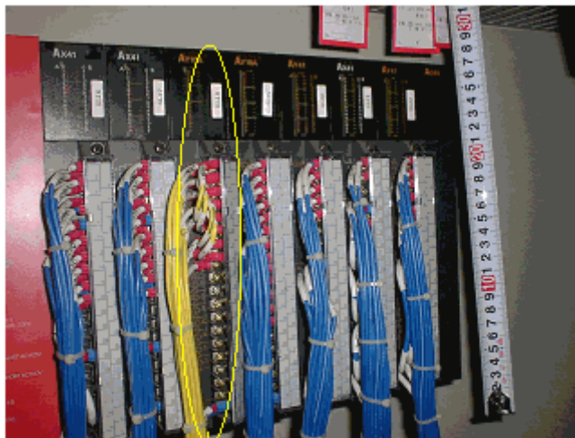
復水器ボール洗浄装置制御盤内部
