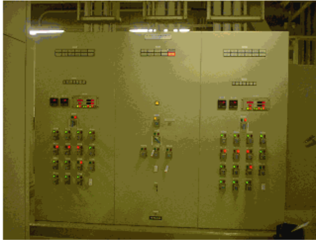
復水器ボール洗浄装置制御盤全景
