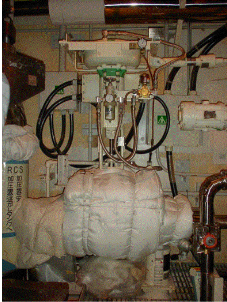
加圧器逃がし弁全景
