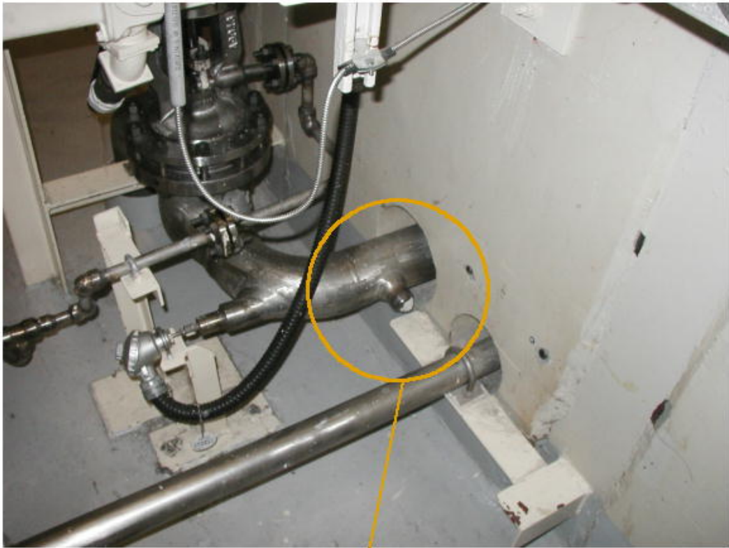
体積制御タンク出口配管全景
