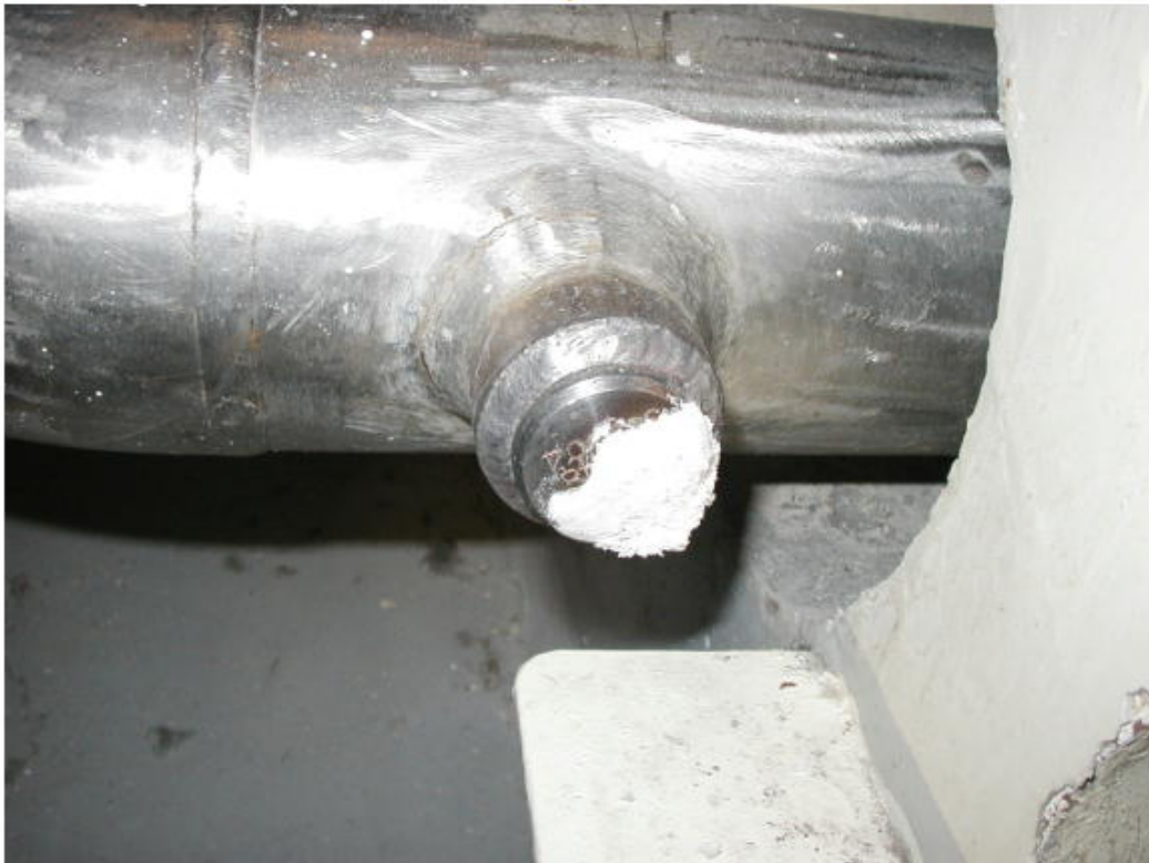
管台拡大写真
