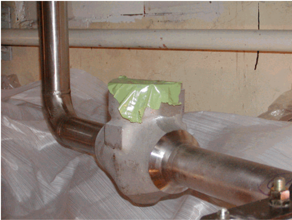
加圧器補助スプレイン逆止弁全景
