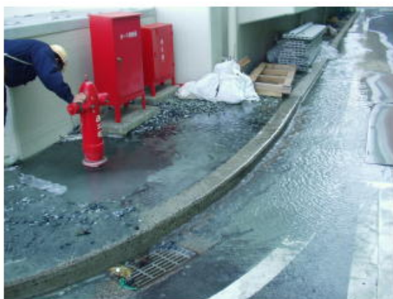
漏洩時の状況
